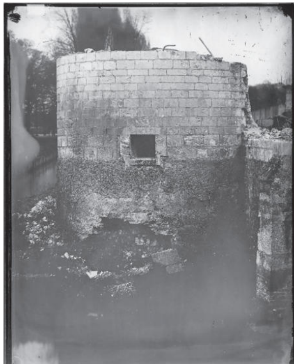
Fig. 11 : la tour Barbazan flquant la porte d'eau du Noyer-aux-Enfants en cours de démolition en 1856 (d'après le négatif sur verre au collodion humide attribué à Alexandre Clausel, MAH, inv. o.1143, plaque B13).
