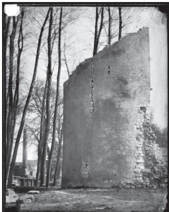
Fig. 13 : la tour Charlemagne avant démolition, vue prise peu avant 1856 (d'après le négatif sur verre au collodion humide attribué à Alexandre Clausel, ADA, 18 FI 07607).
